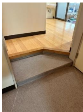
浴場入口の2段の段差は 取り壊しフラットに
