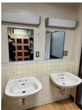
取り外す予定の洗面台
