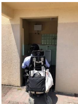
トイレ入口 段差あり
