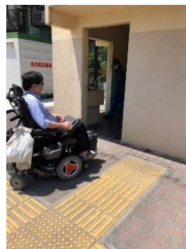
トイレ入口 段差あり
