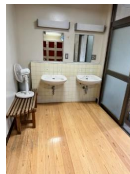
取り外す予定の洗面台
