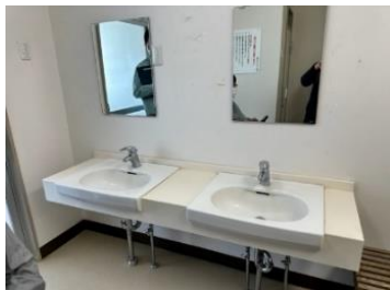
取り外す予定の洗面台
