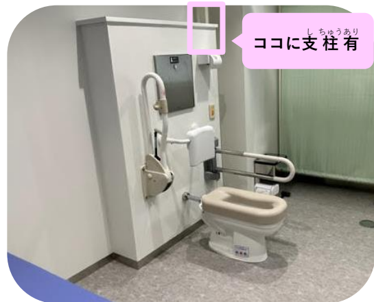
電動ベッドと便座まで、手すり等の設備
